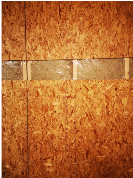
Figur 19 Modulsjøt i ytterveggen
