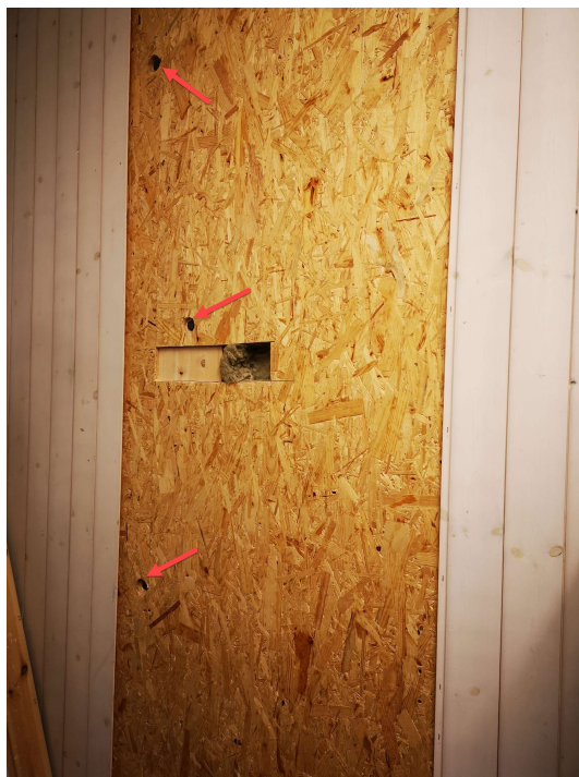
Figur 18 Veggsøylene brukte til å bolte sammen moduler
