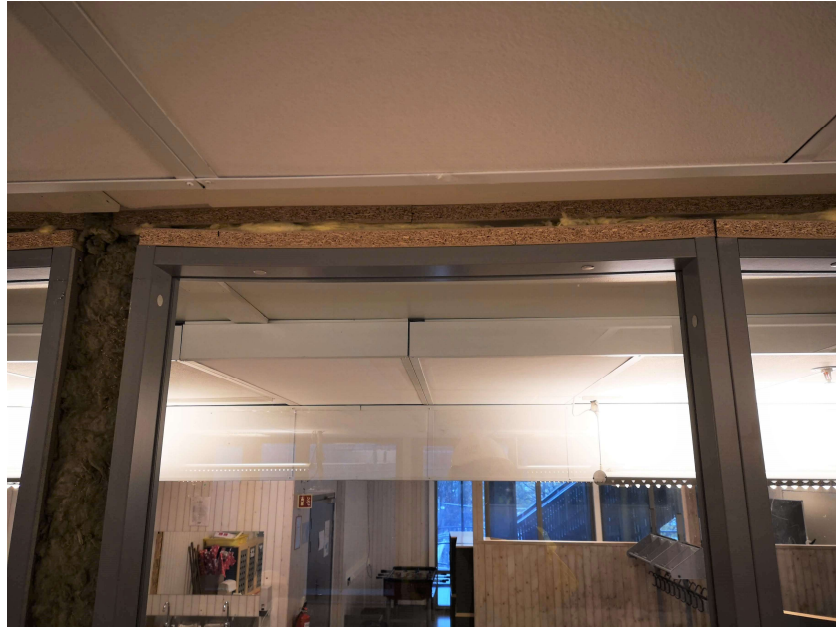
Figur 17 Vindu i spenn i 1. etasje i Bygg 1
