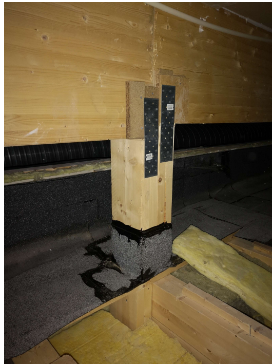
Figur 7 Korte søyler under limtredragere i kryperommet mellom plan 2 og 3
