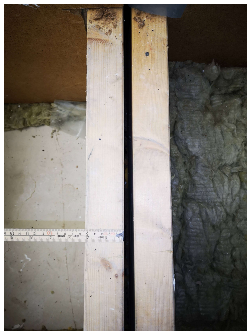
Figur 20 Modulsjøt i taket over plan 2
